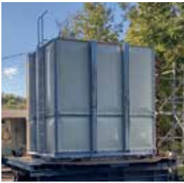
▲外部補強方式 (ボックスフレーム)
