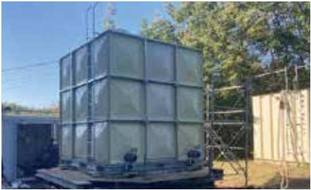
▲内補強方式 (スチールボルト)
