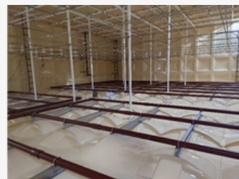
散気配管取付状況
