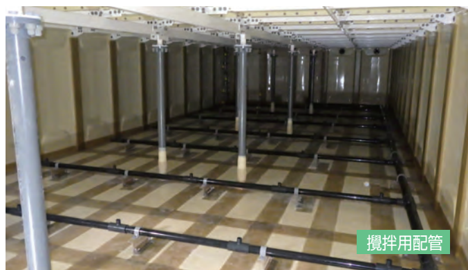
凍結防止溶液貯留タンク
