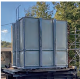
▲外部補強方式（ボックスフレーム構造）
