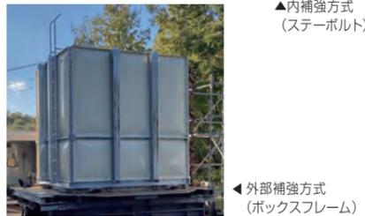
▲外部補強方式(ボックスフレーム)
