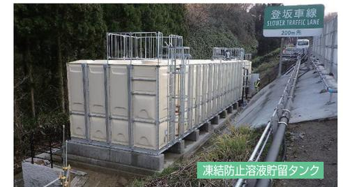
凍結防止溶液貯留タンク
