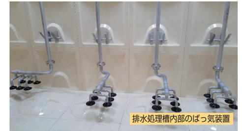
排水処理槽内部のばっ気装置
