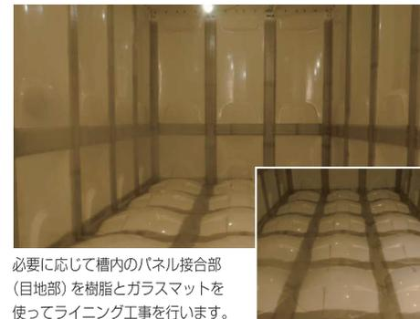
必要に応じて槽内のパネル接合部（目地部）を樹脂とガラスマットを使ってライニング工事を行います。
