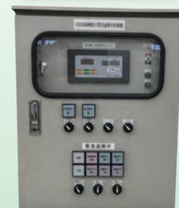
水位設定で最適水量を維持するだけでなく、水槽内の残留塩素濃度も維持し、衛生性を保ちます。
