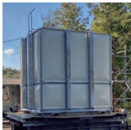
▲外部補強方式 (ボックスフレーム)
