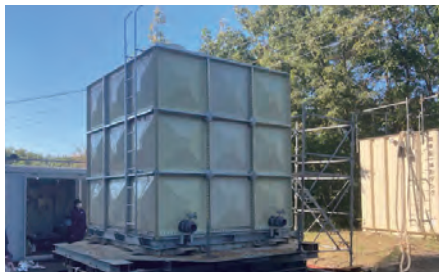
▲内補強方式 (ステーパーボルト)
