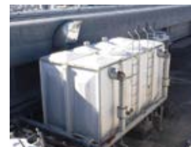
既設2槽式水槽
