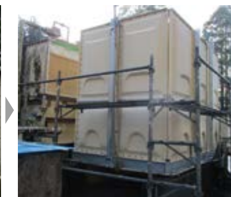
手順2 新設半槽組立
