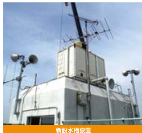
新設水槽設置
