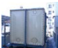
仮設水槽設置
