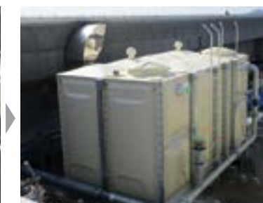
手順4 新設半槽組立・更新完了
