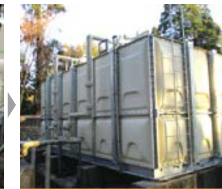
手順4 新設半槽組立・更新完了
