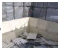
既設水槽解体
