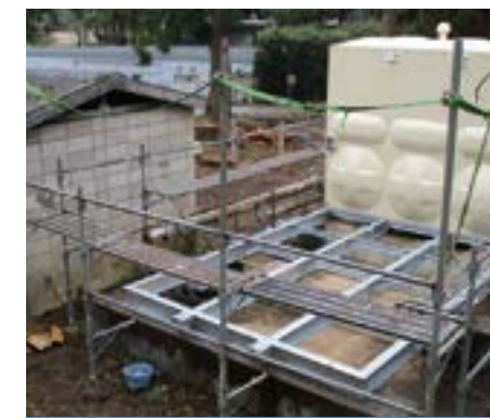
手順3 既設半槽解体
