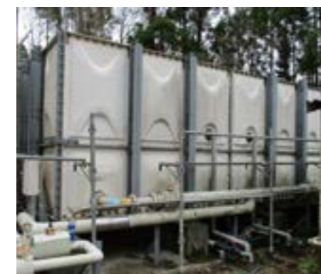
既設2槽式水槽
