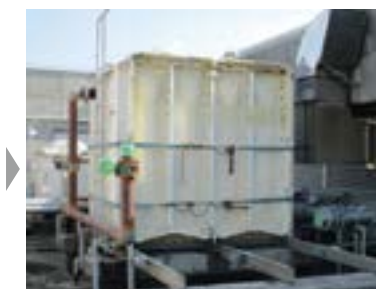
手順1 既設半槽解体
