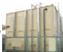
新設水槽組立完了
