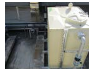
手順3 既設半槽解体
