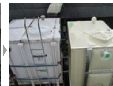
手順2 新設半槽組立
