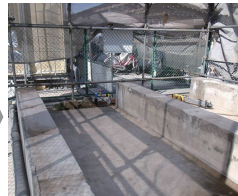
既設水槽解体完了
