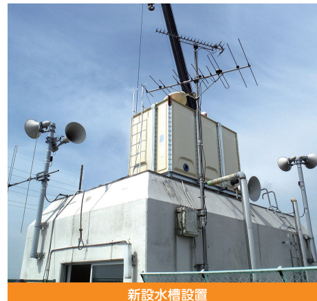
新設水槽設置
