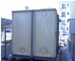
仮設水槽設置
