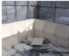
既設水槽解体
