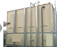
新設水槽組立完了
