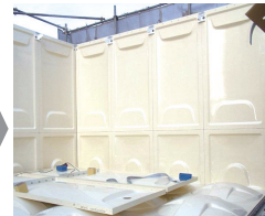
新設水槽組立
