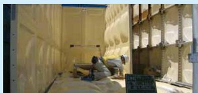
2槽式水槽では建物給水を断水することなく取替工事を行うことができます。居住者様及び建物使用者様のご負担を極力低減できる工法を選定いたします。
