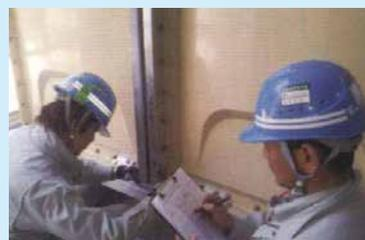
(財)ベターリビング認定の水槽診断士による水槽劣化の調査・診断を実施します。水槽をより長くお使い頂くためのメンテナンスや補修方法や取替について、メーカーならではの最適なご提案をいたします。
