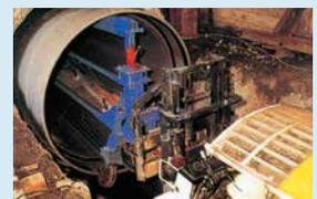
エスロンRCPIによる管路更生工法。カゴ型運搬台車および低重心バッテリーカーで軌条不要の長距離運搬を実現。コストも削減できます。
