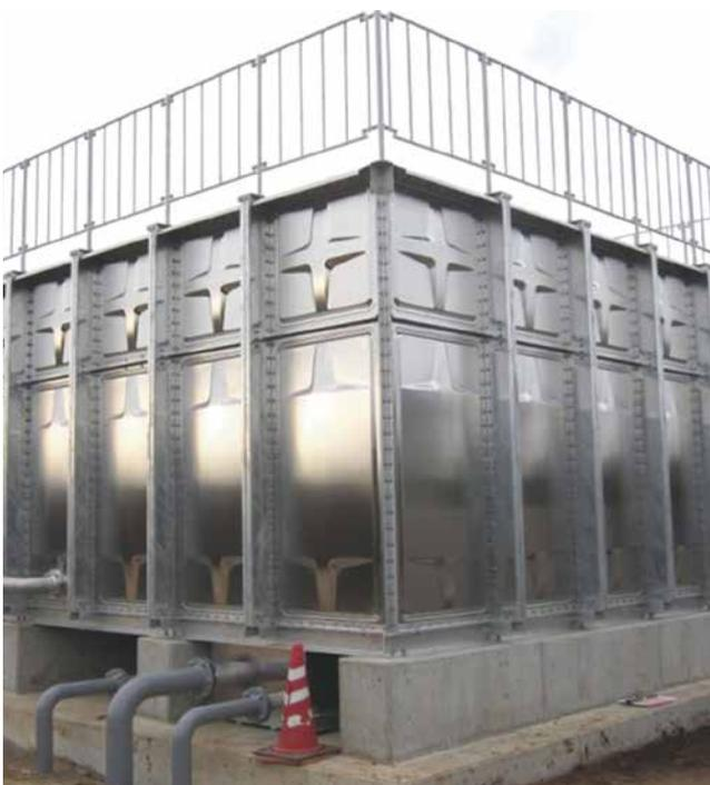
ステンレス製パネルタンク(排水処理用途対応可能)
