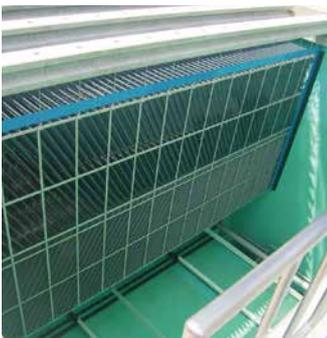
傾斜板沈降装置
