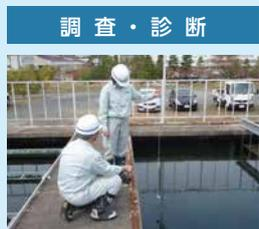
浄水処理過程における、濁度・濁質の分布、流況特性から、既存施設の性能評価を実施いたします。
