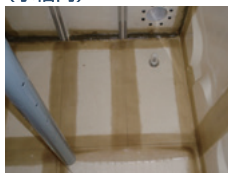
FRP補修工事 (水槽内)
