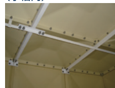
補強部材補修工事 (水槽内)
