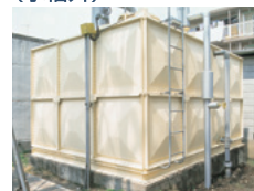
外観リフレッシュ塗装工事 (水槽外)
