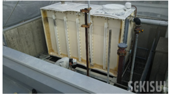
2-高置水槽を半分撤去
