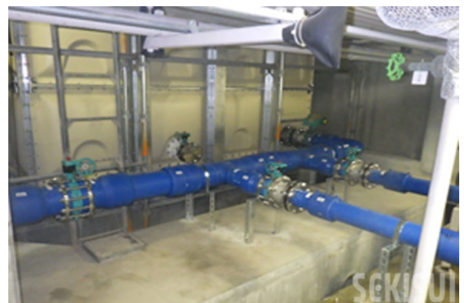
更新後の管路
