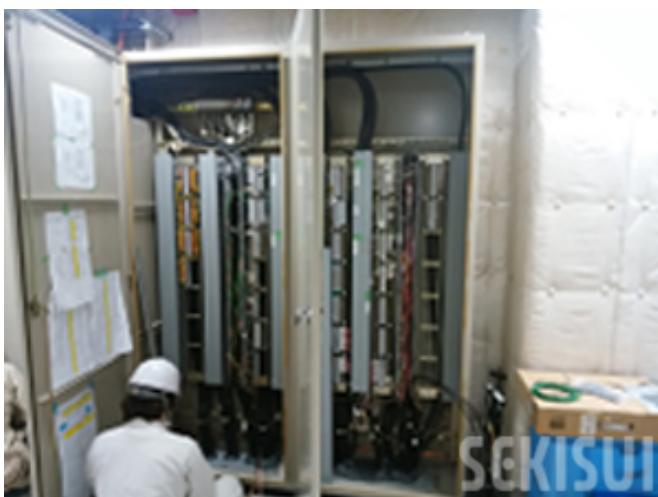
既設リモート盤改造（中央監視への情報取込み）
