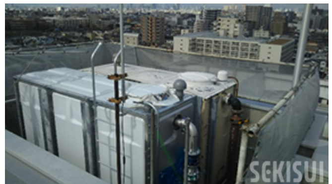
3-既設の水槽を運用しつつ、撤去した箇所に水槽を新設
