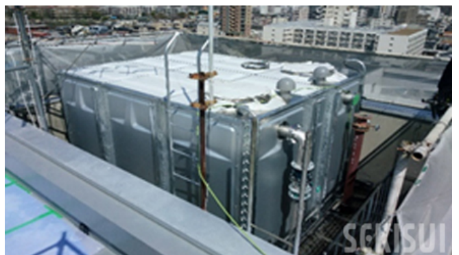
4-新設した水槽を運用しつつ、残り半分の既設の水槽を撤去して、新たな水槽を設置
