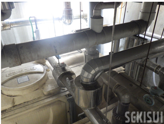
改修前（狭く入り組んだ配管）
